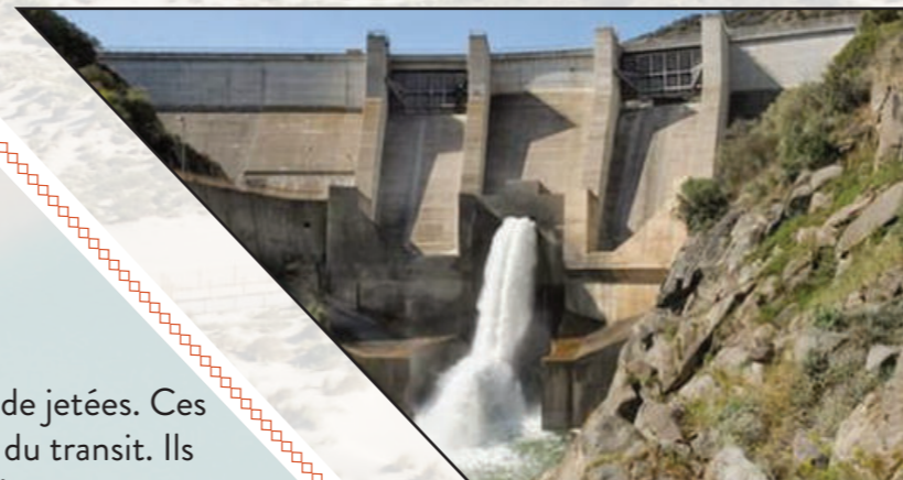
Le barrage du Vinça, sur la rivière Têt (66)
