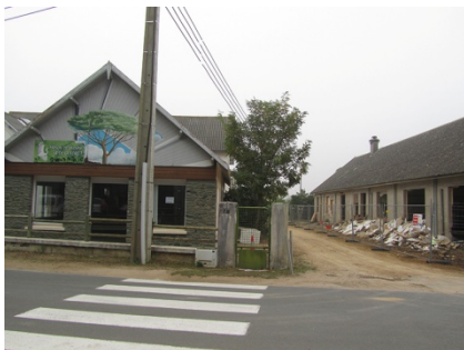
La Maison de la Dune et de la Forêt avant sa démolition.
